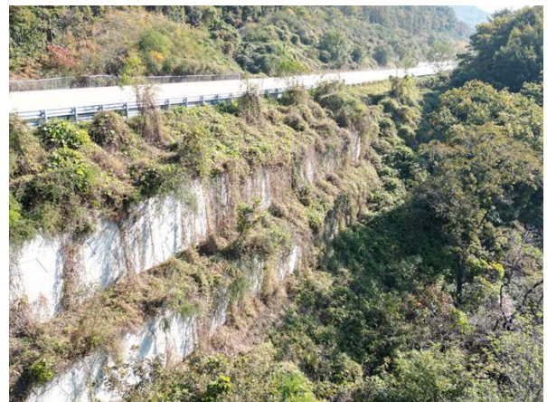
상부 성토부 전경
