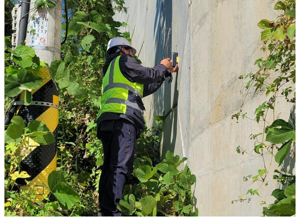
경사계를 이용한 경사도 측정사진
